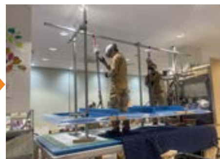
■天板吊り上げ
